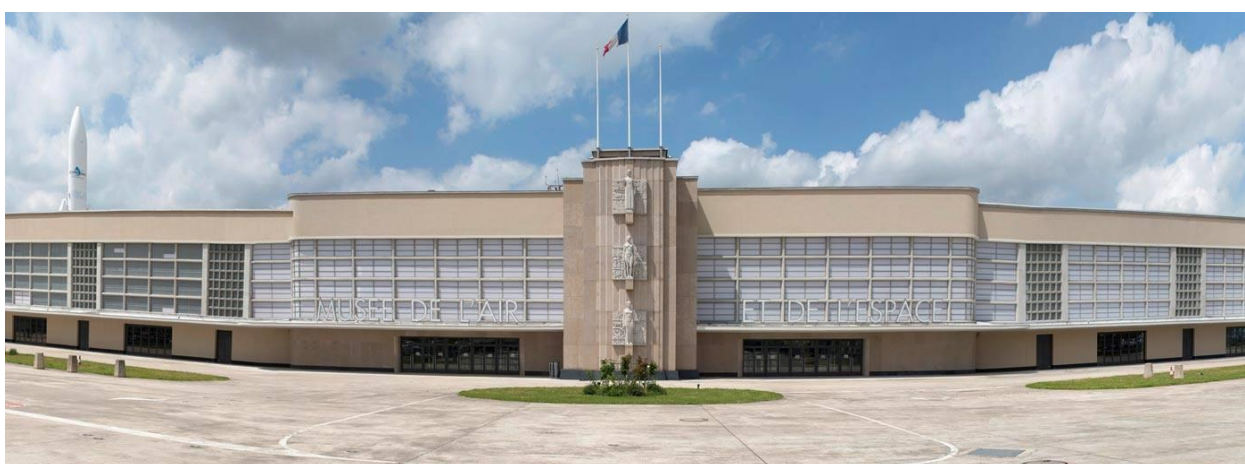
Il. 4.12 Fasada terminalu po remoncie. Źródło: Oficjalny profil Musee de l'Air et de l'Espace na portalu Facebook, 04.09.2018, https://www.facebook.com/museedelairretdeespace/photos/10155742524528807/ [dostęp: 20.03.2021].
