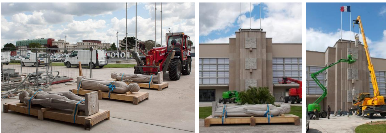
Il. 4.11. Renowacja rzeźb umieszczonych na fasadzie muzeum. Źródło: Profil Musee de l'Air et de l'Espace na portalu Facebook, 03.04.2015, www.facebook.com/museedelairretdelespace/photos/a.10152929431888807/10152929432048807/?type=3&theater [dostęp: 20.03.2021].
