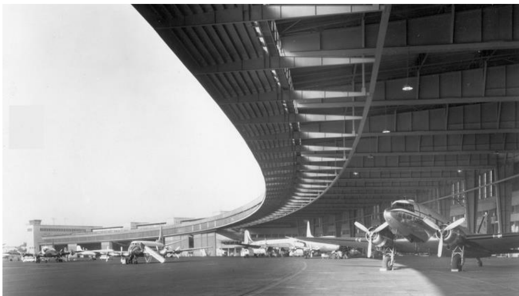
Il. 1.35. Lotnisko Tempelhof, widok od strony pasów startowych, widoczny zakrzywiony kształt dachu. Źródło: http://www.retronauta.pl/berlin-tempelhof-niedoszly-centralny-port-lotniczy-swiata [dostęp: 20.03.2021].
