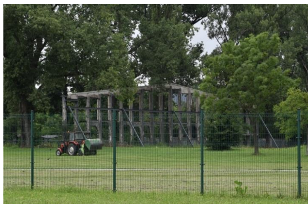
Il. 4.47. Pozostałości po Hangarze 5, ściana, 2021 r. Fot. A. F. Szuta.
