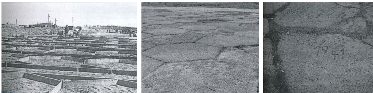
Il. 1.06. Ilustracja po lewej: Sześciokątne formy przygotowane do zalania betonem. Ilustracja w środku: zdjęcie z lat 90. XX wieku pozostałości pasa startowego, widoczne sześciokątne płyty z 1941 r. Ilustracja po prawej: Betonowa płyta z wyrytym rokiem 1941, prawdopodobnie przez sowieckiego pracownika. Źródło: M. Nikiciuk, Krywlany. Białostockie lotnisko , Białystok, 2012, str. 42, 70.
