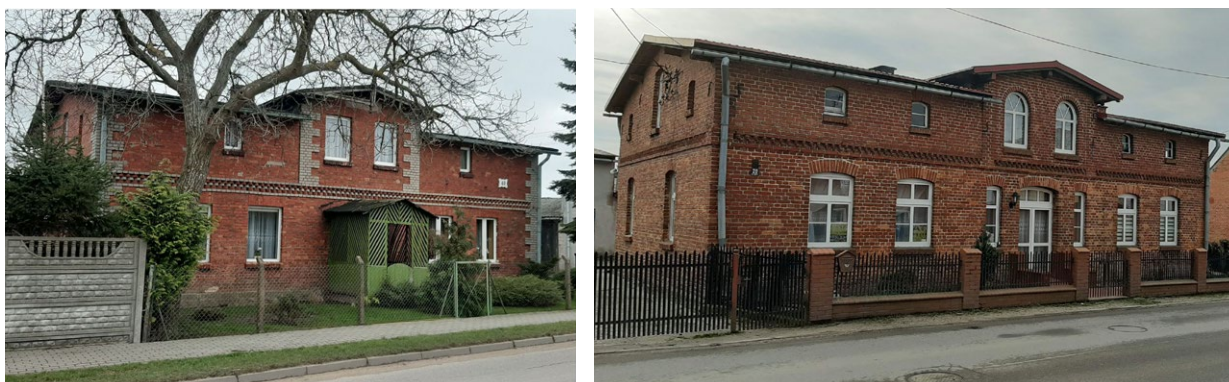
Ryc. 1. Ceglane domy z dachem półpłaskim w gminie Puck, od góry: dom w Żelistrzewie, elewacja zachodnia; poniżej dom w Polchowiu, elewacja północna, 2020; oprac. M. Szarejko
