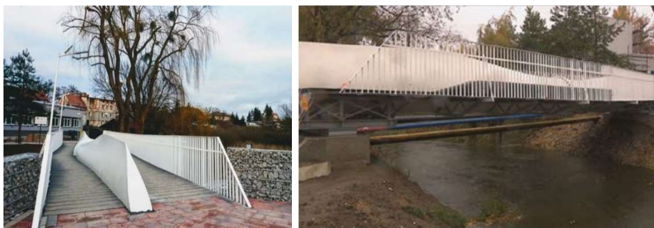
Rys. 6. Kładka dla pieszych wykonana przez firmę ANMET w Szprotawie [23]
