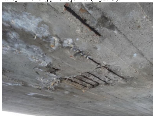
Rys. 3. Spód płyty pomostu
