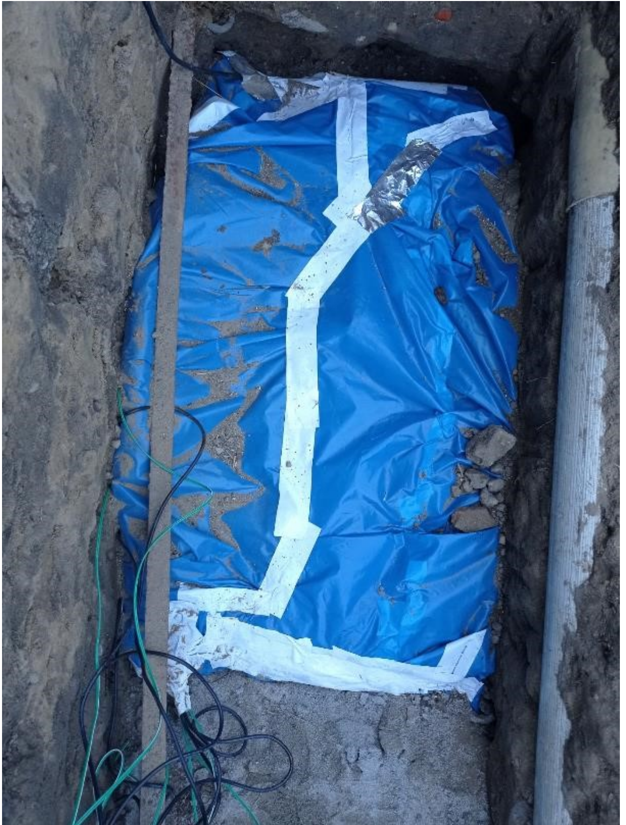
Rysunek 47. Zakończenie uszczelniania folii na stanowisku
