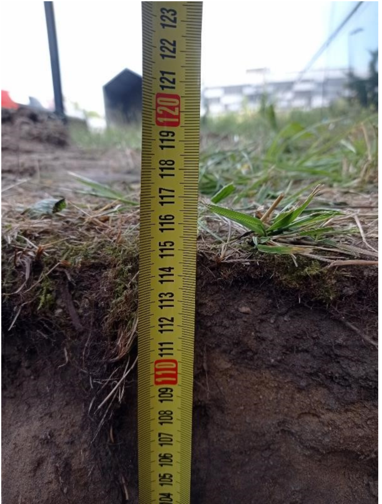
Rysunek 40. Pomiar głębokości rowu kablowego
