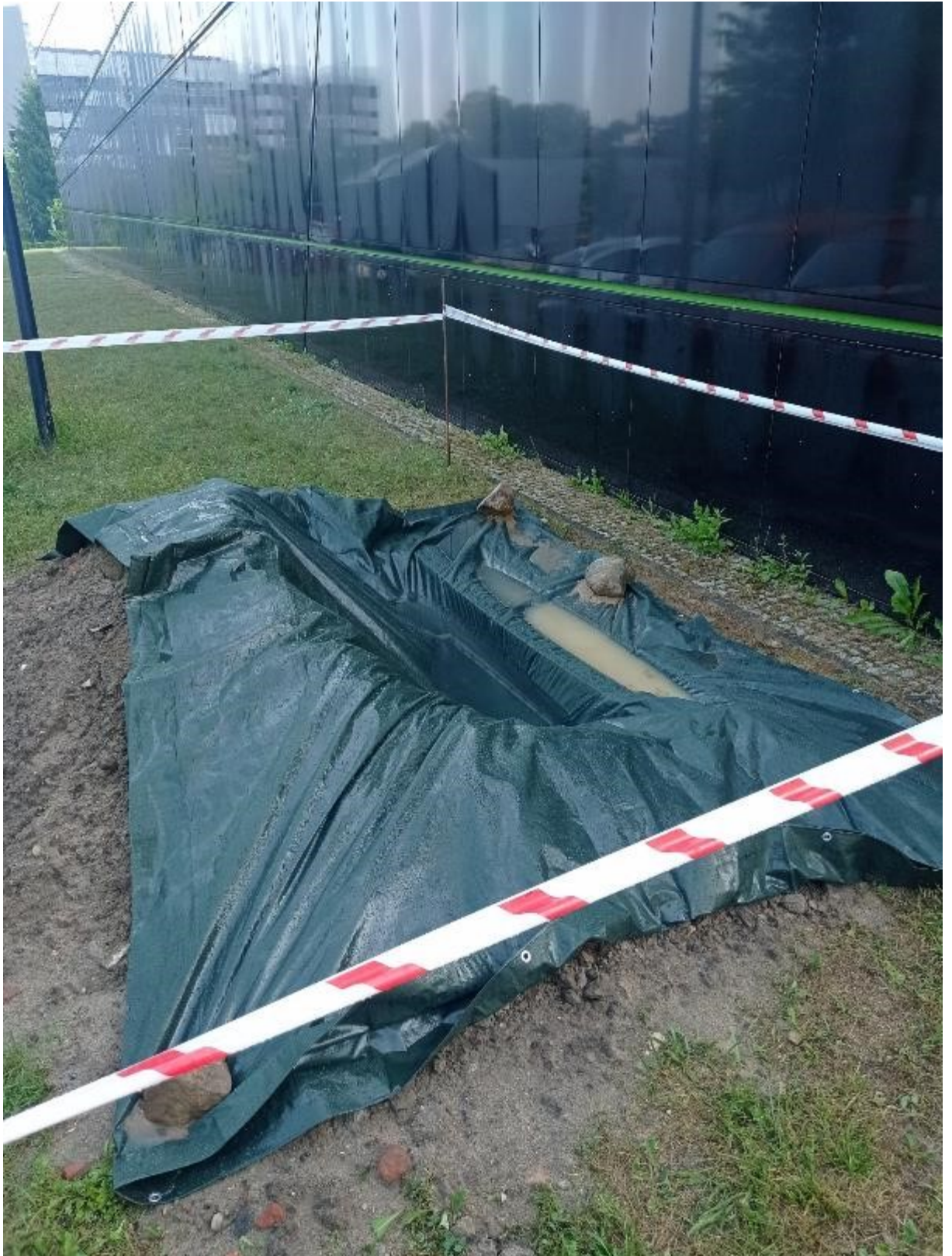
Rysunek 41. Zabezpieczenie stanowiska przed wpływem opadów atmosferycznych
