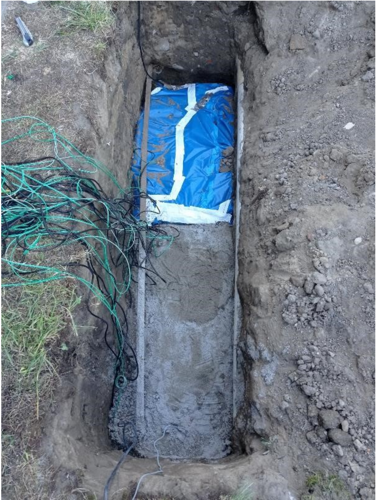
Rysunek 48. Widok na stanowisko pomiarowe przed zasypaniem go ziemią rodzimą
