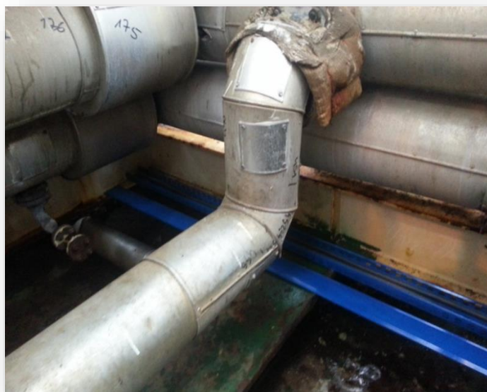
Rysunek 49. Przebieg korytka kablowego, w którym zainstalowano przewody od czujników pomiarowych.
