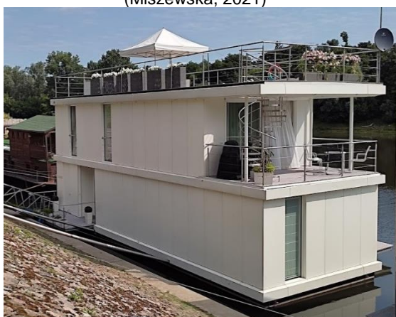
Rys. 3.29. Port Czerniakowski – Domy Na Wodzie – widok 3. (Miszevska, 2021)
