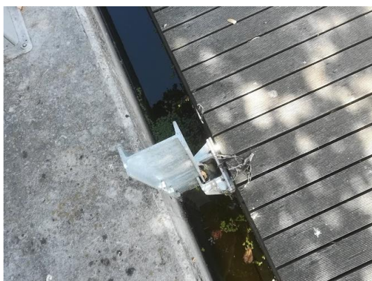
Rys. 3.63. Kotwiczenie z zastosowaniem suwaka. (Miszevska, 2018)
