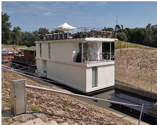
Rys. 3.50. Dom pływający – obiekt 1, kanał Czerniakowski, Warszawa. (Miszevska, 2021)
