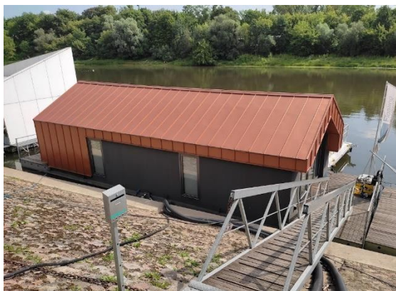
Rys. 3.27. Port Czerniakowski – Domy Na Wodzie – widok 1. (Miszevska, 2021)
