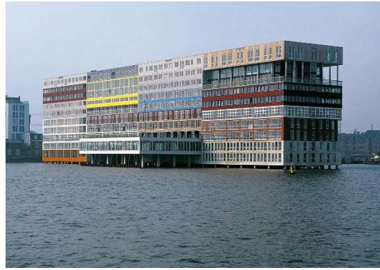
Rys. 3.49. Apartamentowiec Silodam wykonany na palach, Amsterdam, Holandia. (AV, n.d.)
