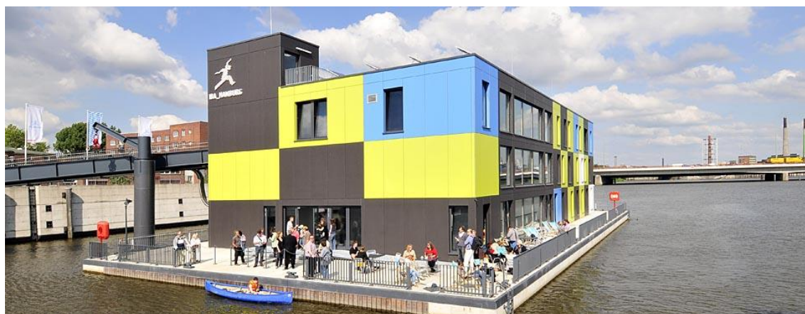
Rys. 3.15. Największy w Niemczech budynek wystawienniczo-biurowy zbudowany w porcie celnym w Müggenburg. Obecnie siedziba IBA Hamburg GmbH od 2010 r. (IBA Hamburg GmbH, n.d. c)
