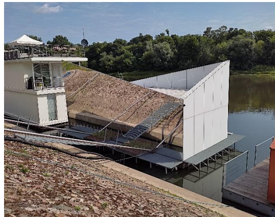
Rys. 3.51. Dom pływający – obiekt 2, kanał Czerniakowski, Warszawa. (Miszevska, 2021)
