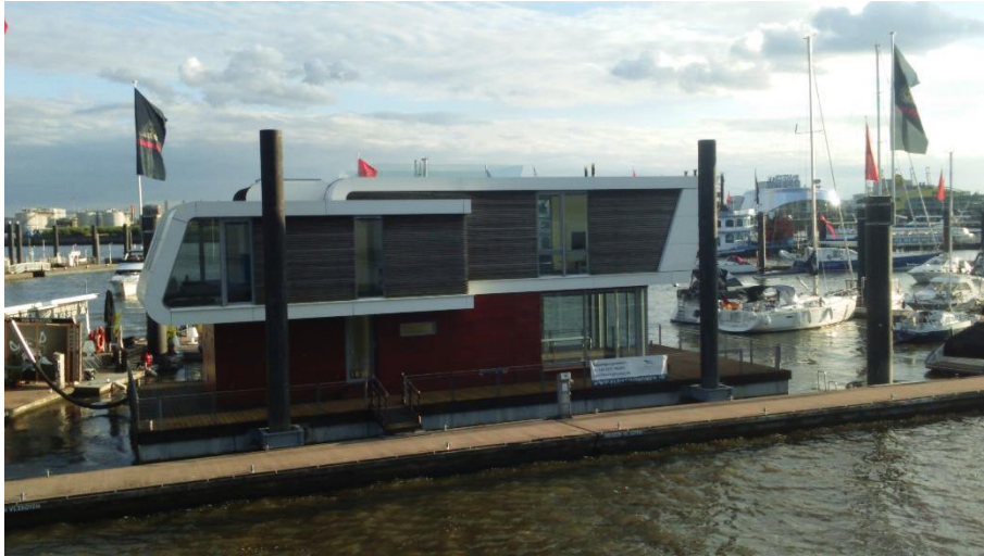
Rys. 3.16. Dom mieszkalny na wodzie w Haffencity, Niemcy. (Miszewska, 2019)
