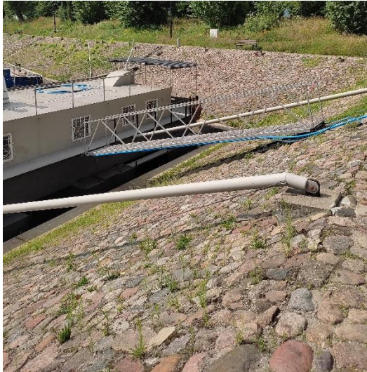
Rys. 3.65. Bomy cumownicze utrzymujące barkę mieszkalną na kalanie Żerańskim, Warszawa. (Miszevska, 2021)
