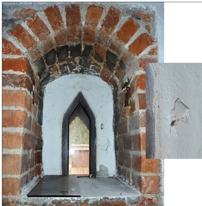
Ryc. 2. Okienko w elewacji południowej oraz hak od skobla do zamykania okiennicy; autorem wszystkich współczesnych fotografii i rysunków jest K. Darecka Fig. 2. Small window in the south facade and the hook for the staple for closing the shutter; all contemporary photos and drawings by K. Darecka
