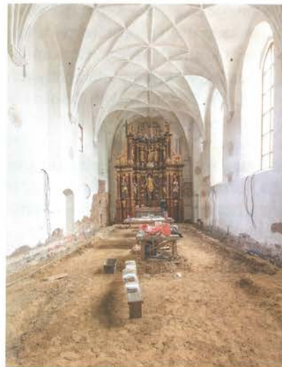
13. Barczewo. Kościół Świętego Andrzeja. Prezbiterium w trakcie prac konserwatorskich, 2021. Fot. Damian Kwiecień – Gorek Restaura.
