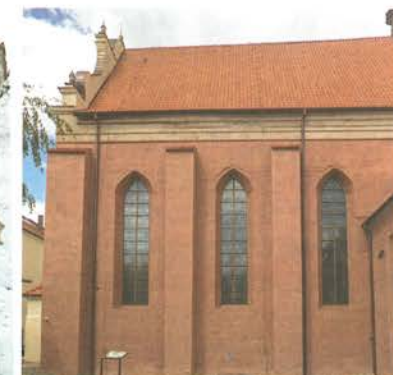
10. Barczewo. Kościół Świętego Andrzeja. Elewacja wschodnia, stan po konserwacji z rekonstrukcją kolorowych tynków, trzech dużych okien i sygnaturki, 2022 roku. Fot. Damian Kwiecień – Gorek Restaura.
