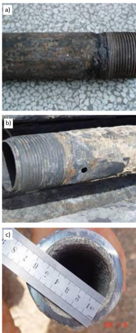
Rys. 9. Widok rur okładzinowych wydobytych z odwiertu na polu naftowym TARIM [22]. Widok zewnętrznej powierzchni rury – rys. a) i b), oraz wewnątrz rury – rys. c).
