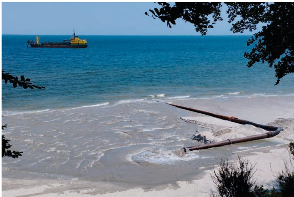
Rys. 5. Pogłębiarka ssąco-nasiębierna Inż. Stanisław Łęgowski podczas refulacji w Babich Dołach (06.2023) (materiały własne)
