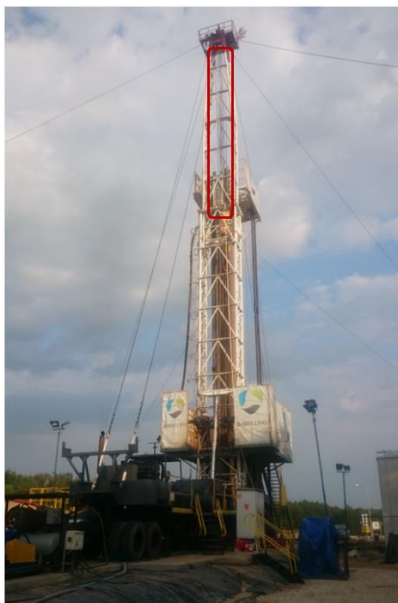
Rysunek 65 Wiertnia z widocznym systemem bloczkowym umożliwiającym zapuszczanie i wyciąganie kolumny rur
