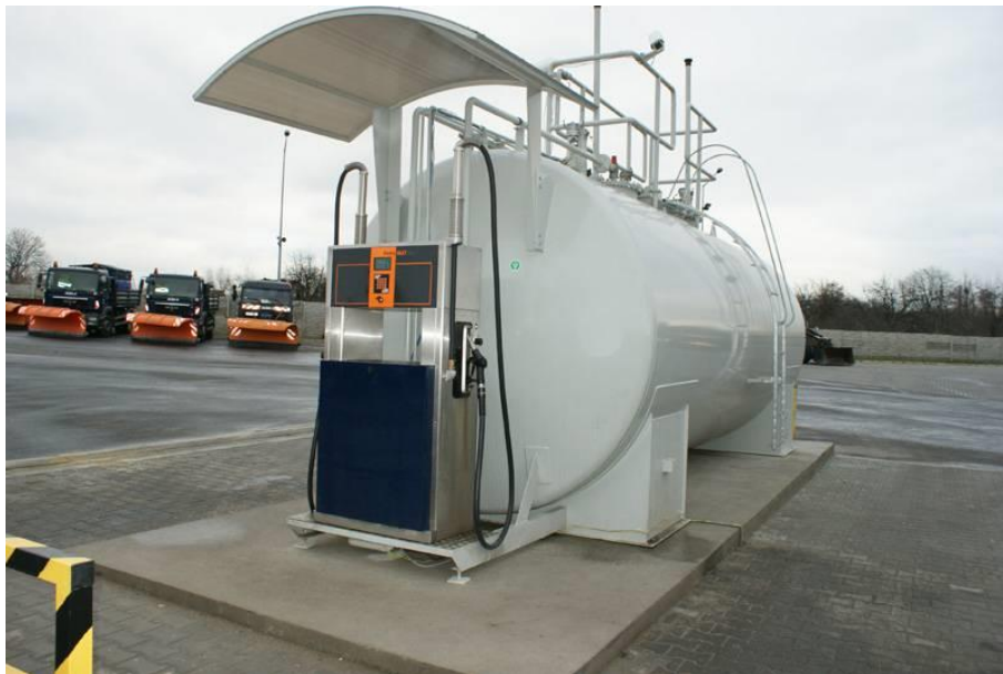
Rys. 2.4. Zbiornik cylindryczny poziomy do magazynowania paliw płynnych klasy III – oleju napędowego i opałowego lub benzyn ( https://petroconsulting.pl )
