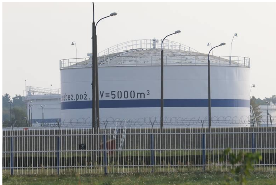
Rys. 2.2. Zbiornik z dachem stałym zlokalizowany na terenie Bazy Paliw nr 2 OLPP Sp. z o.o. w Nowej Wsi Wielkiej ( http://pomorska.pl )
