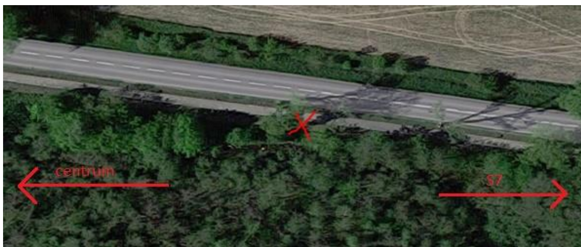
Rys. 57. Położenie punktu pomiarowego. Odległość punktu od drogi S7 585 m.
