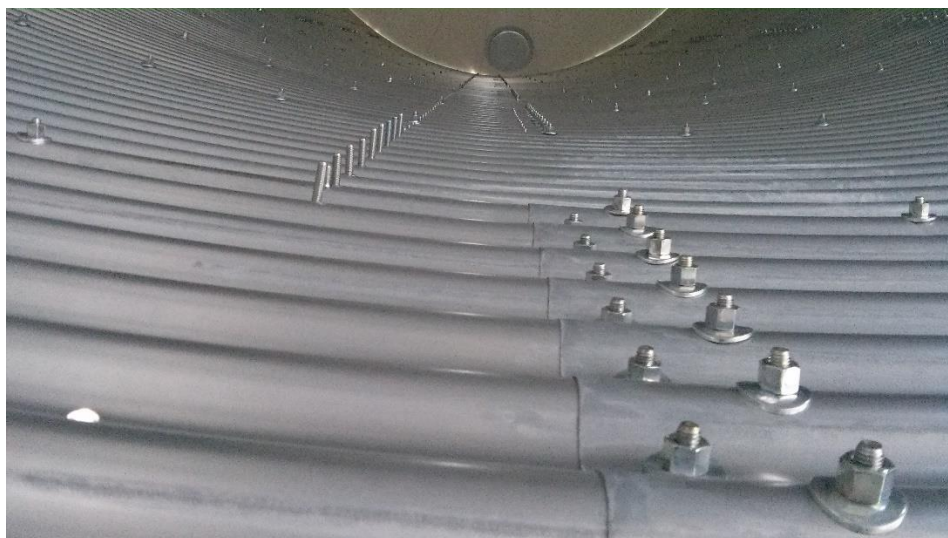
Rys. 1.4: Wnętrze silosu – połączenie śrubowe arkuszy blachy falistej.
