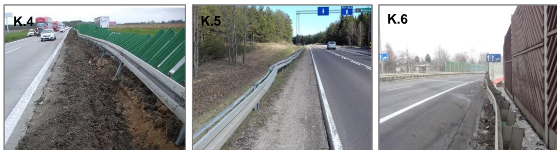
Rys. 5.10 Grupy zdarzeń K.4-K.6 wywołane najechaniem pojazdu na barierę ochronną
