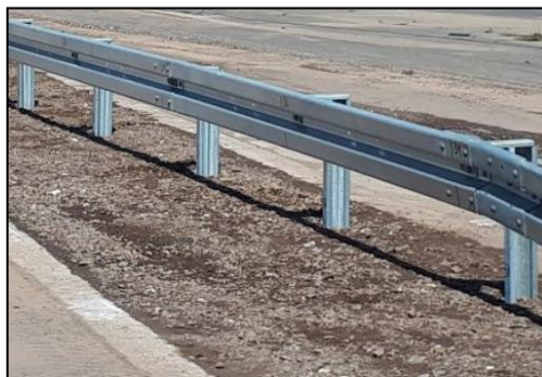
Rys. 2.10 Bariera z prowadnicą stalową
