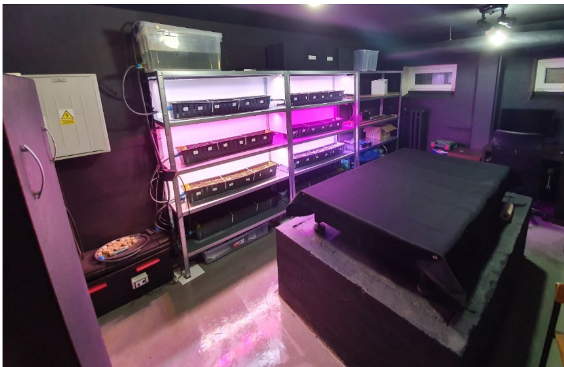
Rys. 7. Widok stanowiska badawczego w formie farmy wertykalnej.
