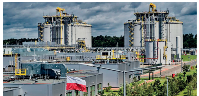
Fig. 1. LNG storage base in Świnoujście, Poland ( https://www.gaz-system.pl/pl/terminal-lng/informacje-o-terminalu-lng.html )
