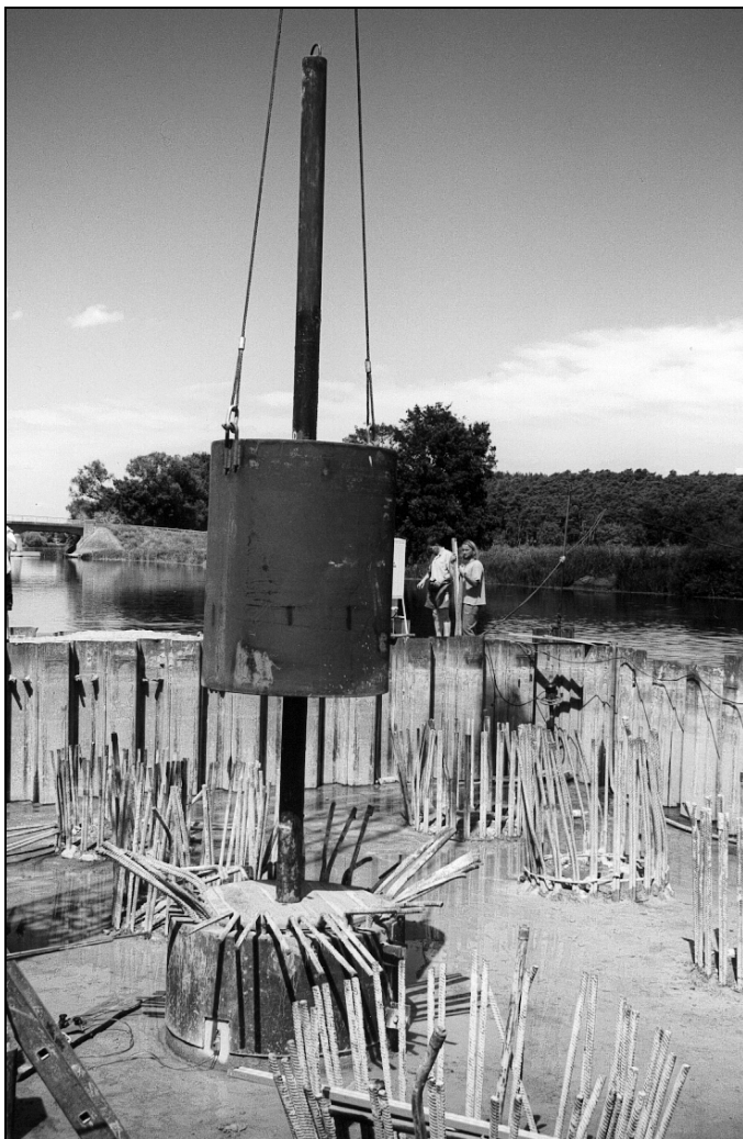
Rys. 3 Stanowisko badawcze pala wierconego \phi 1500 mm. Bijak przygotowany do uderzenia w głowicę pala
