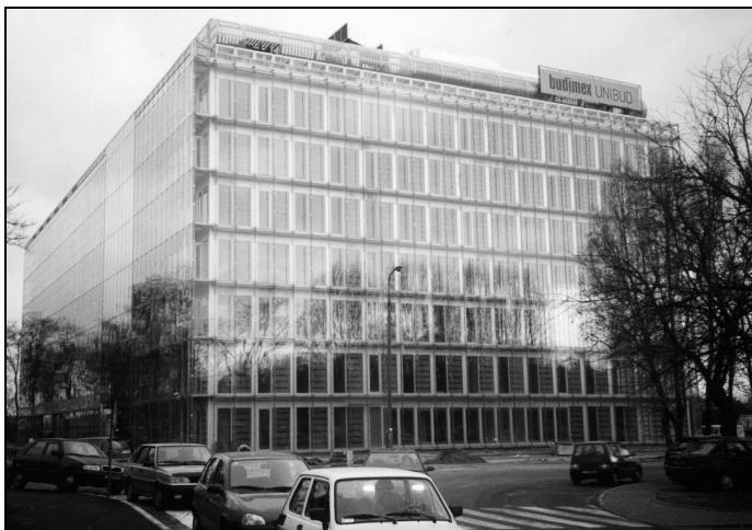
Rys. 10 Widok budynku PLL LOT (październik 2001)
