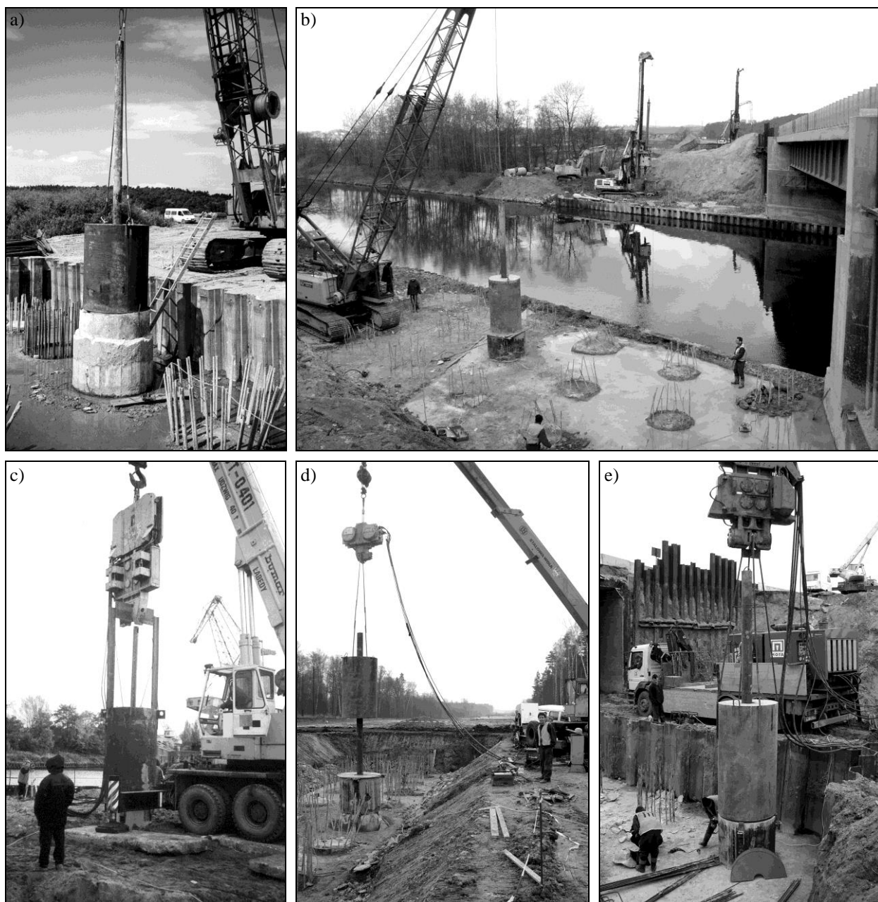
Rys. 6. Dynamiczne badania nośności pali wierconych:
