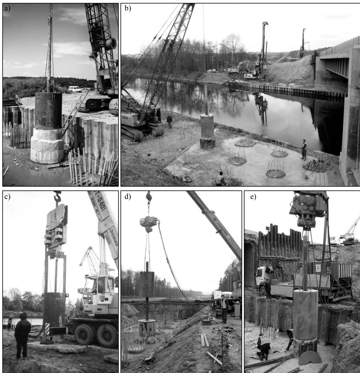
Rys. 5. Dynamiczne badania nośności pały wierconych:
