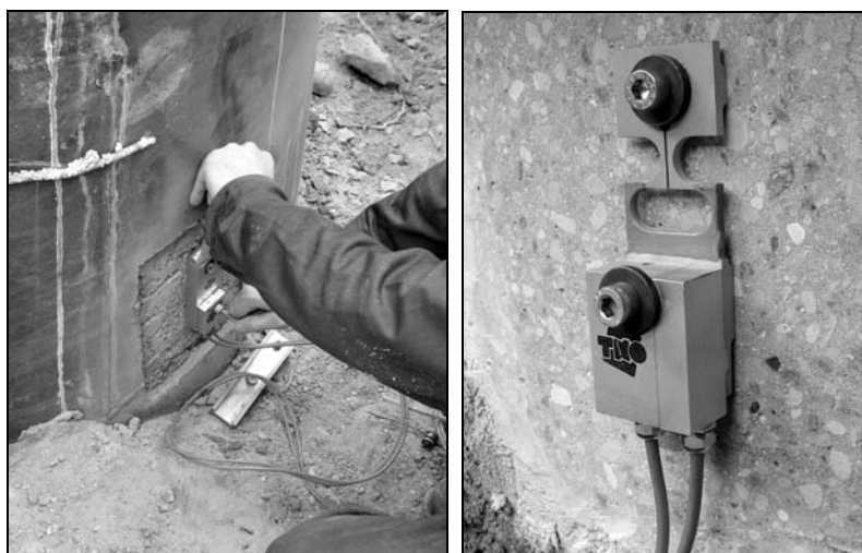
Rys. 4. Czujniki zamontowane na palu
